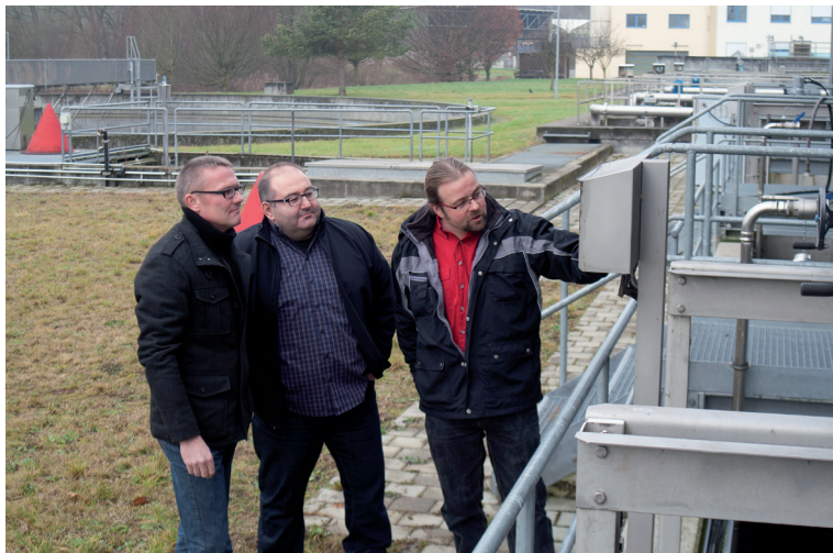
Besichtigung der 4. Reinigungsstufe. Von links nach rechts: Patrick Link-Walter und Maik Wötzel, Vertriebsrepräsentanten Grundfos, und Carsten Bucksch, Abwassermeister.
