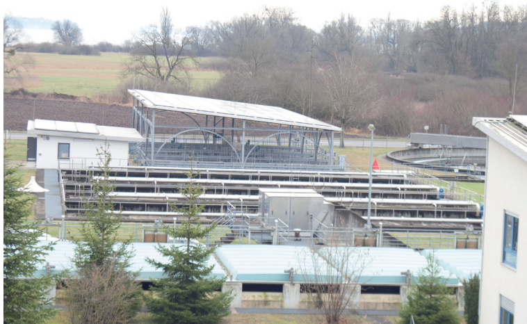
Kläranlage Stockacher Aach in Bodman-Ludwigshafen
