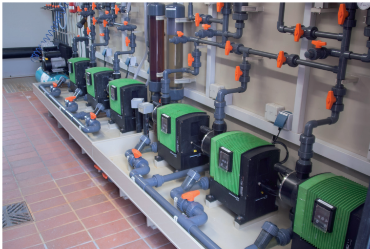
Dosierstation für die Zugabe von Fällmitteln Kläranlage Stadt Pforzheim.
